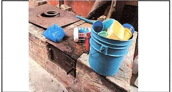
Foto 2: Son 3 planchas en mal estado y están muy bajas.
