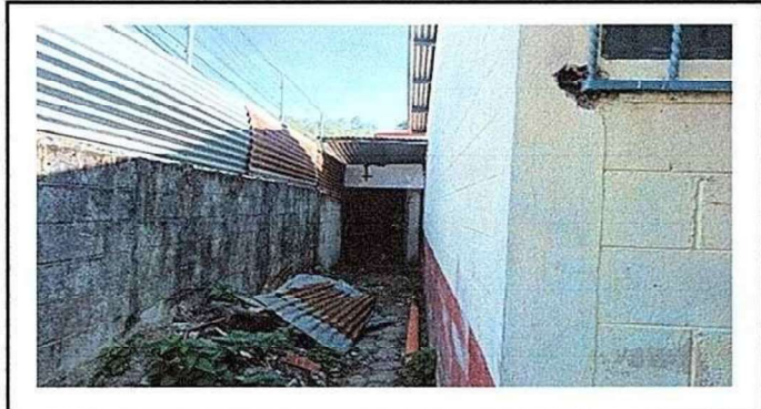
Foto 1: espacio lleno de monte y se le colocará concreto
